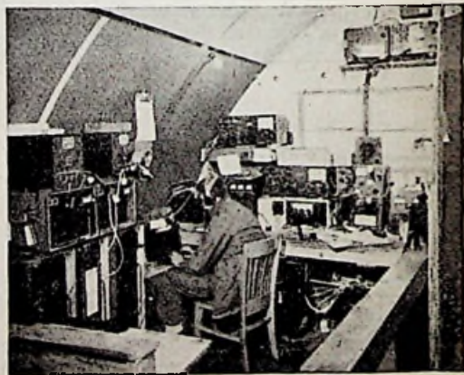
Fig. 2. In het tijdelijke kamp op het Zuidpoolijs, in een z.g. Quonset-hut, werd een met normale apparaten uitgerust Marine-radiostation ingericht. Het 96 voet lange metalen bouwsel, dat tevens huisvesting bood, deed bovendien dienst als tegen-capaciteit voor de zenders.
